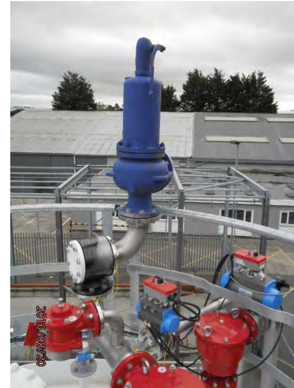
Válvula de seguridad
